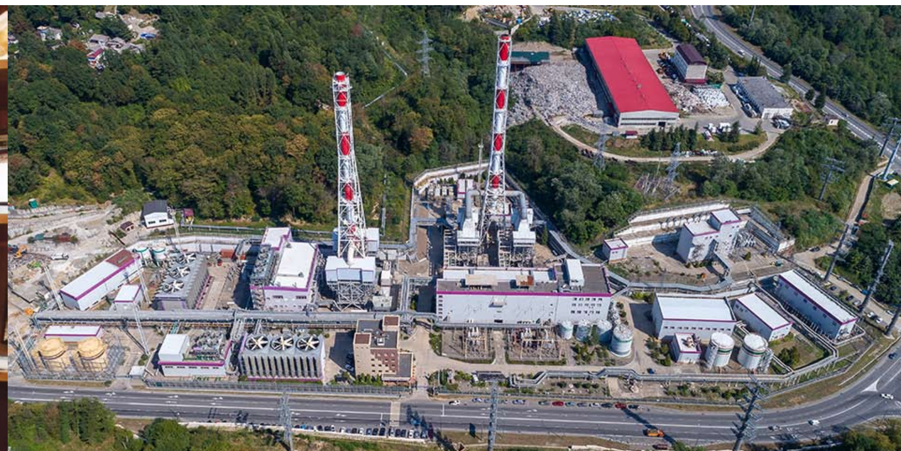
Сочинская ТЭС введена в эксплуатацию в 2004 г.
