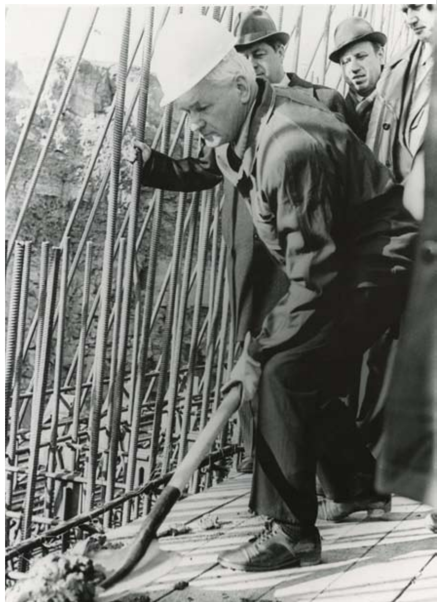
Закладка первого куба бетона в дымовую трубу Березовской ГРЭС-1 при участии министра топлива и энергетики СССР П. С. Непорожного. 23 апреля 1981 г.
