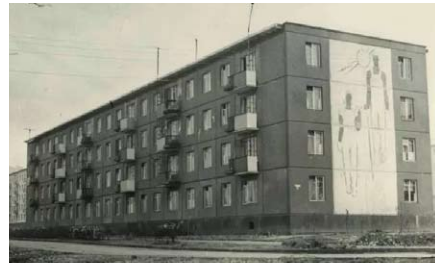
Один из новых 48-квартирных жилых домов в микрорайоне «Белая ромашка». Пятигорск, 1964 г. Строительство микрорайона началось в 1958 году с прокладкой трамвайной линии. Спустя несколько месяцев появились первые жильцы. А первая его улица стала носить название «Имени Патриса Лумумбы». К 1963-му контуры микрорайона уже обозначились.
