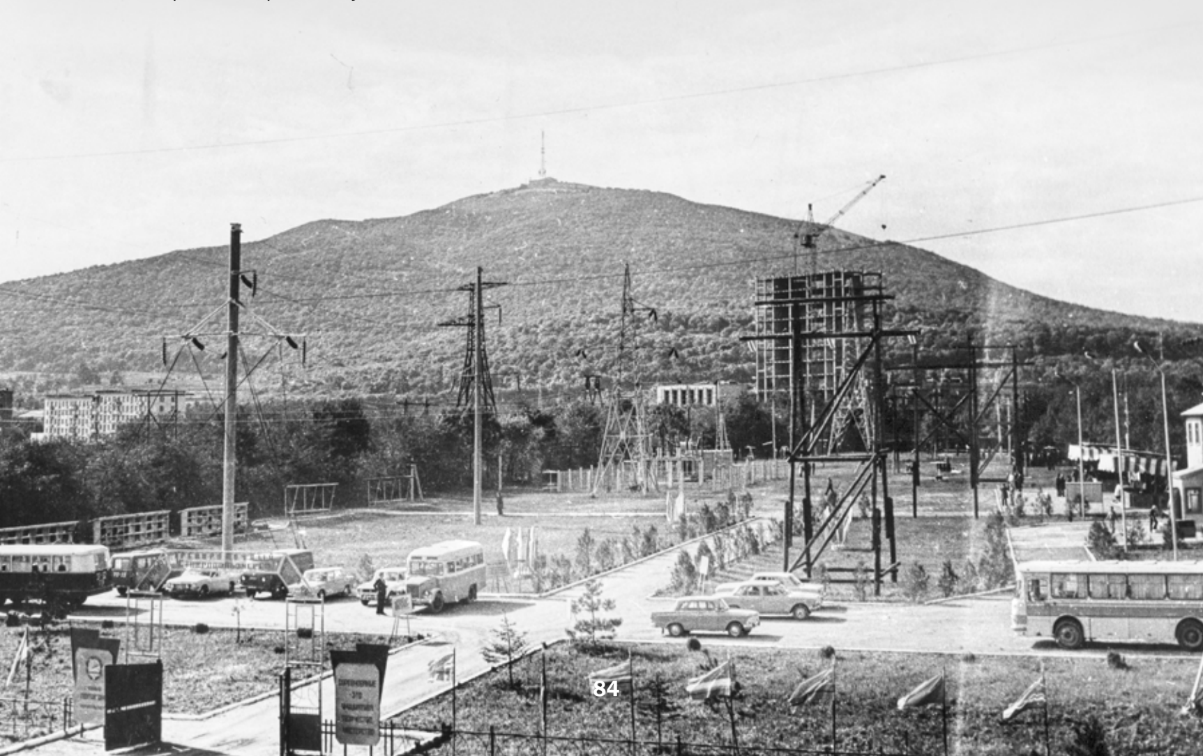
Строительство учебного комбината Ставропольэнерго и его учебного полигона.
